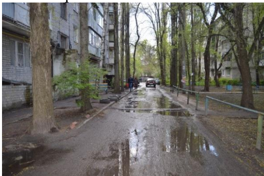
Рис. 1. Транспортно-пешеходная зона во дворе дома по ул. Ворошилова
